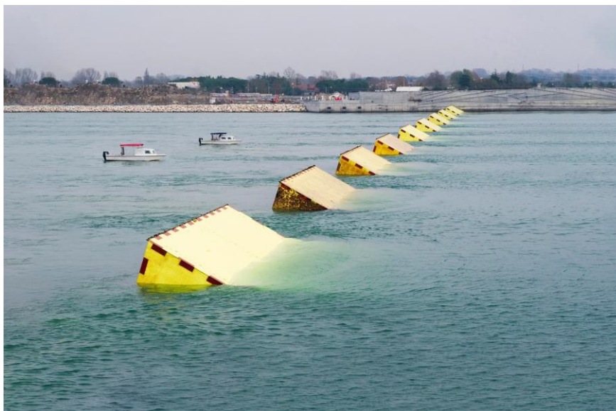
Figura 2-6: Le paratie mobili del MoSE di Venezia alle bocche di porto.
